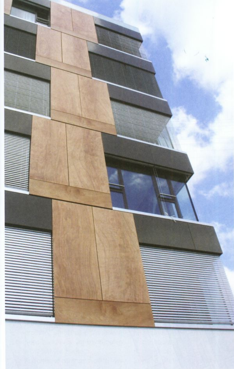
▲ NH HOTEL – detail fasády
